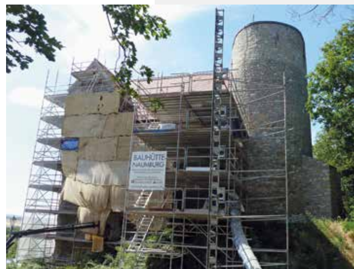
Seit Mai sind auch die Sanierungsarbeiten an der Ostfassade abgeschlossen.
