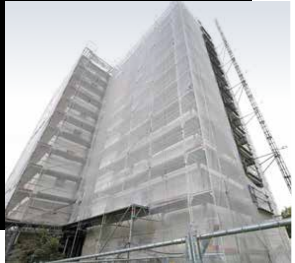
Hoch hinaus: Mit dem Baustellen-Aufzug ging es bis zum Dach hinauf.
