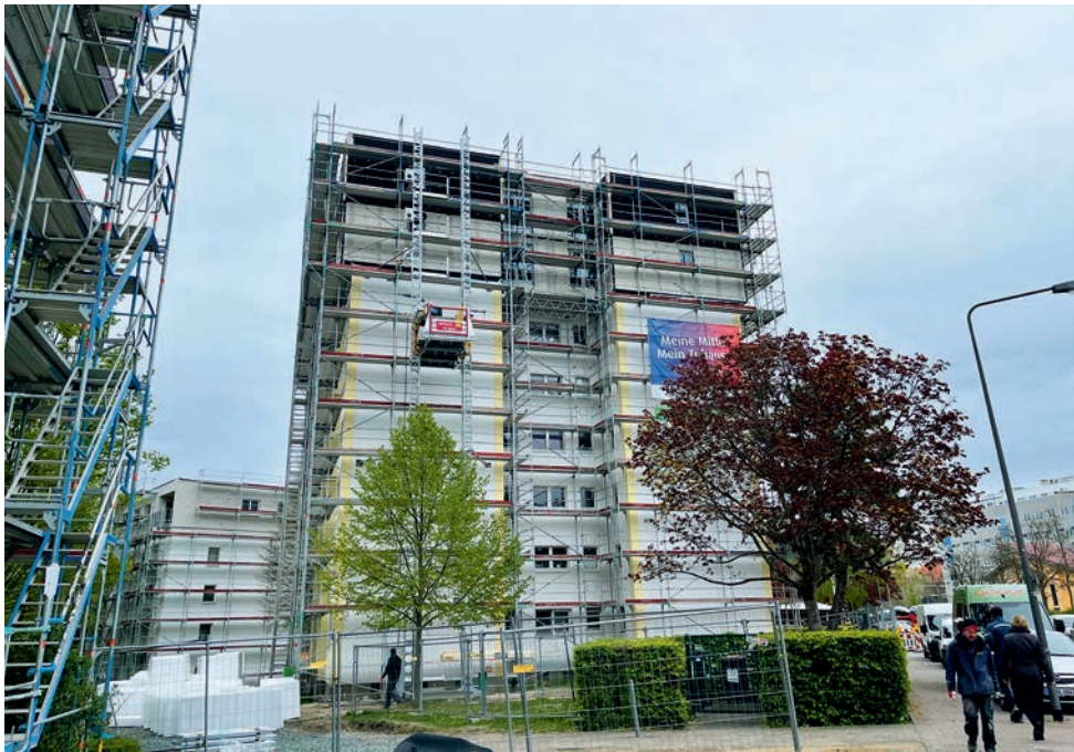
Mithilfe von vorgefertigten Holzmodulen konnten die Gebäude ganz einfach um zwei Geschosse erweitert werden.
